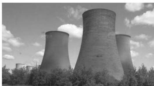
Chimenea de enfriamiento.
